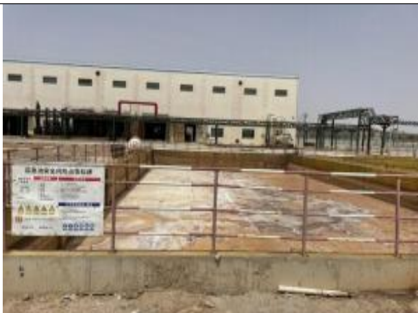
厂区事故应急池
